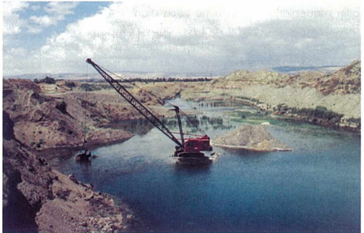
Açığa çıkan yeraltısuyu içerisinde sallama kepçelerle yapılan derin kazılar
